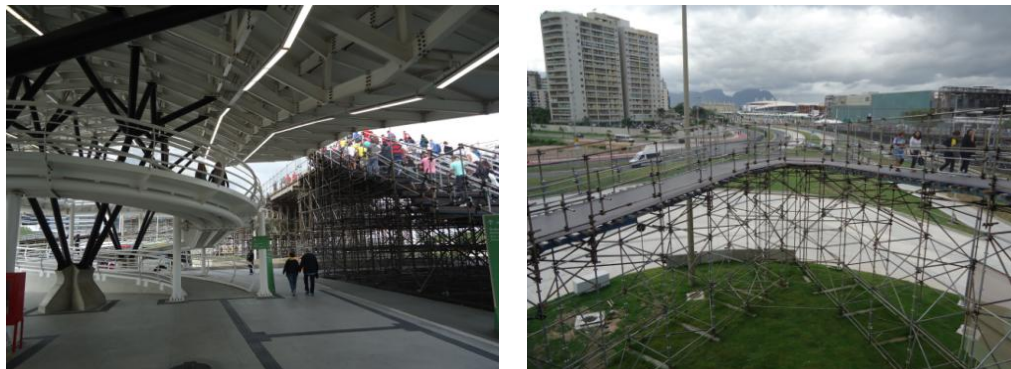
【競技会場で見られた仮設建造物（例）】
